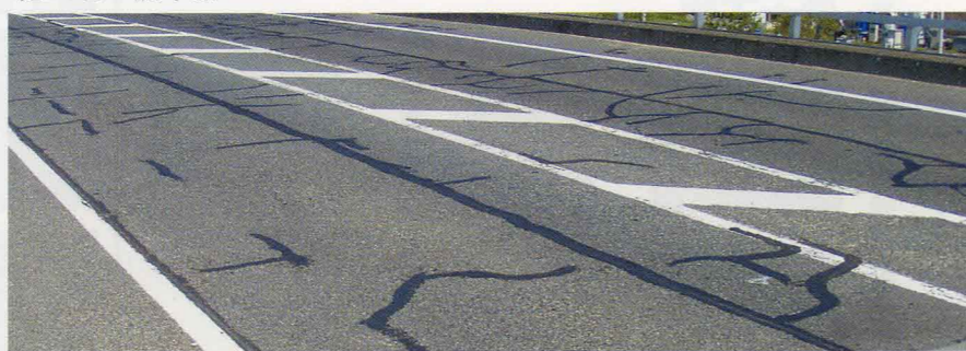
施工地：熊本県
