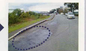
施工地：熊本県
