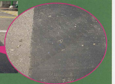
舗装とジョイントの継目や表面に損傷は見られない。
